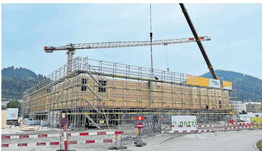
Derzeit werden die vorgefertigten Holzelemente bei der Dreifachturnhalle Rietwis in Wattwil montiert.
